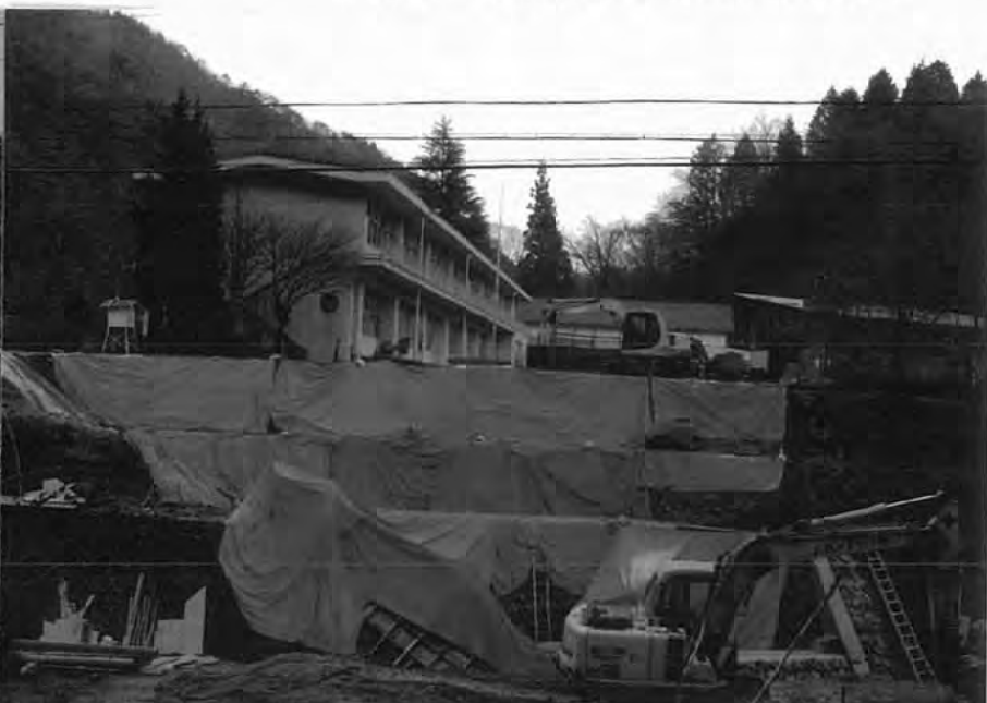
写真 4 工事中的様子
