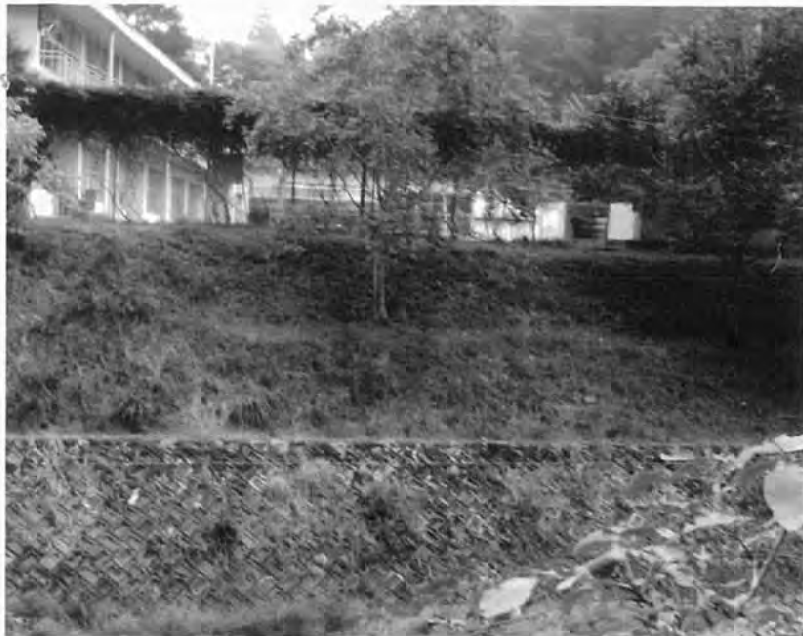
写真 1 校庭東側護岸の工事前
