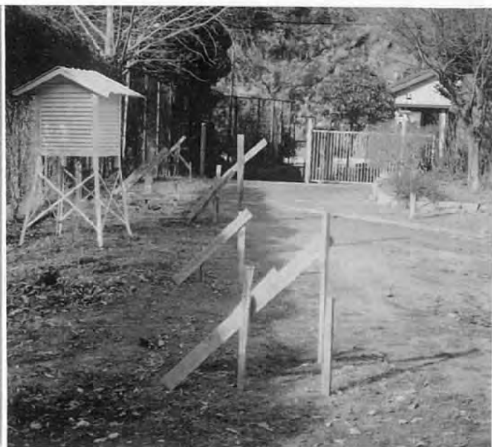
写真 2 校庭を掘り込む範囲の杭打ち
