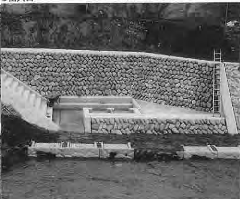
写真4 はぼ完成した観察施設
