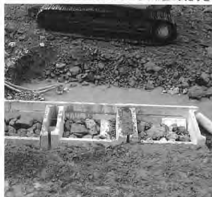
写真3 はんざきブロックの内部状況
