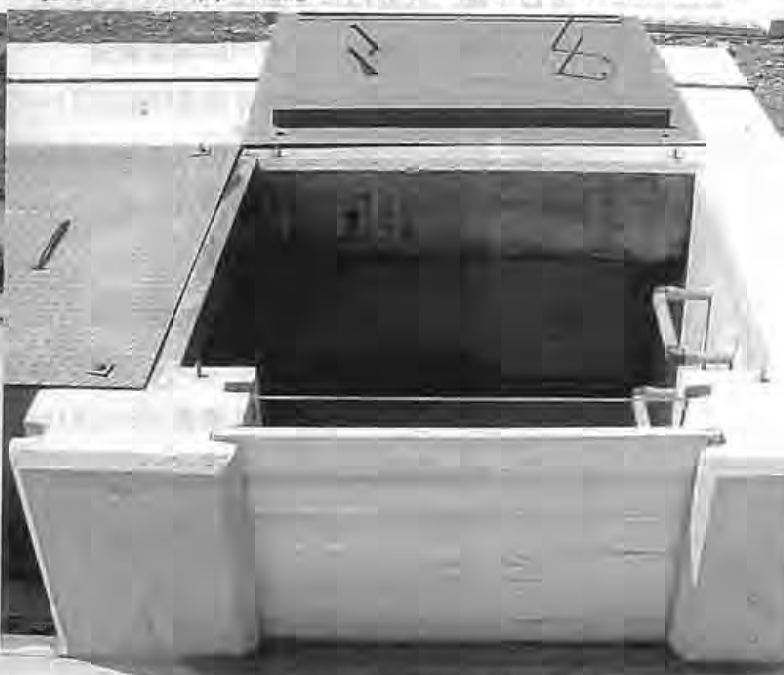
写真4 観察施設のガラス窓と雨戸
